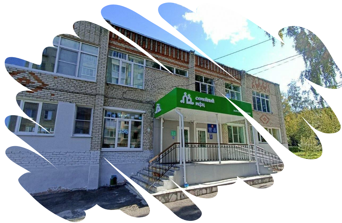
Чувашская Республика, г.Чебоксары, ул. Гузовского, д.26 (Московский район)
