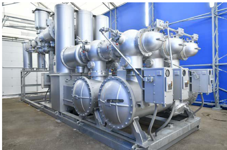
Комплектное распределительное устройство с элегазовой изоляцией (КРУЭ) в НИУ «МЭИ»
