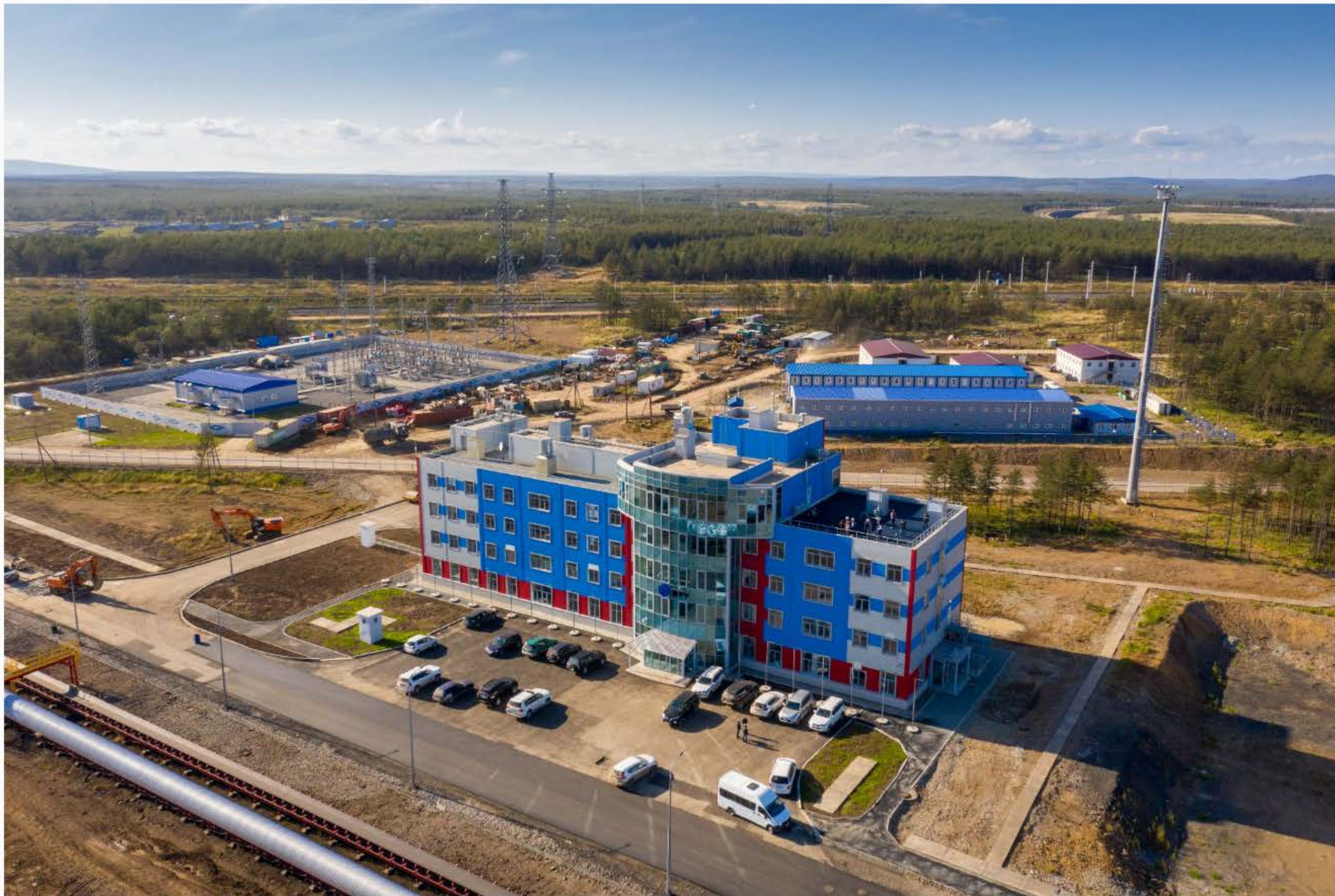
Транспортно-перегрузочный комплекс по перевалке угля АО "ВТУ"
